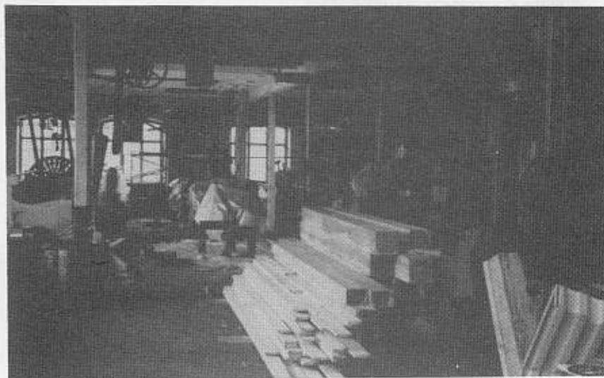
Reparation av takbjälkar inne i maskinhallen -92.
